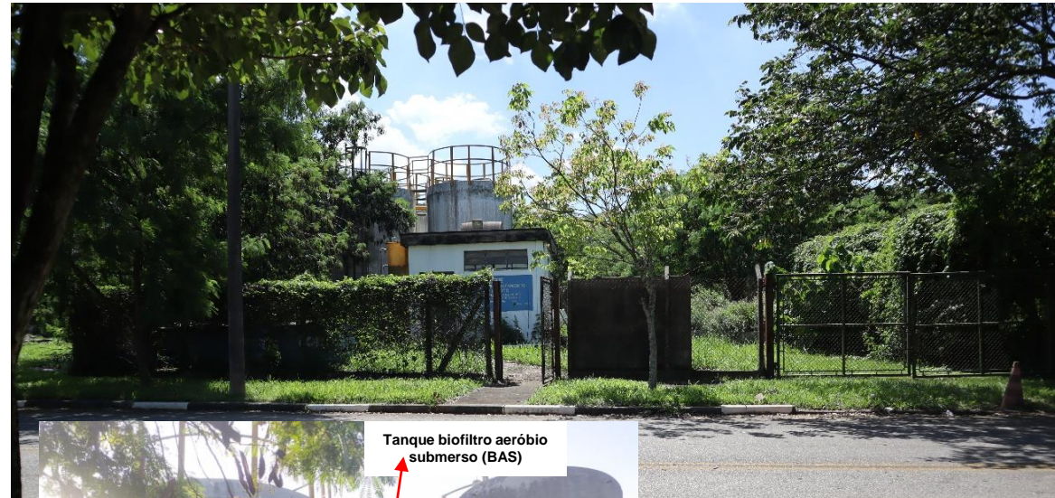
Fig. 1: Vista frontal da ETE - Produção de Água de Reuso (EACH)
